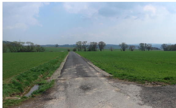
Bild 4: Beginn der Neubaustrecke von Espenau kommend.
