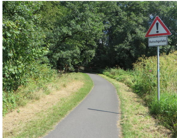
Bild 2: Schmale Strecke im Bereich der Landesgrenze mit Warnhinweis auf die rutschige Holzbrücke
