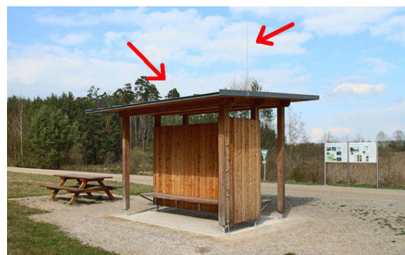
Bild 4: Fränkisches Seenland: Dieser Radwanderrastplatz am Großen Brombachsee besitzt eine blitzschutzsichere Schutzhütte mit Metaldach und zwei Blitzableitern.
