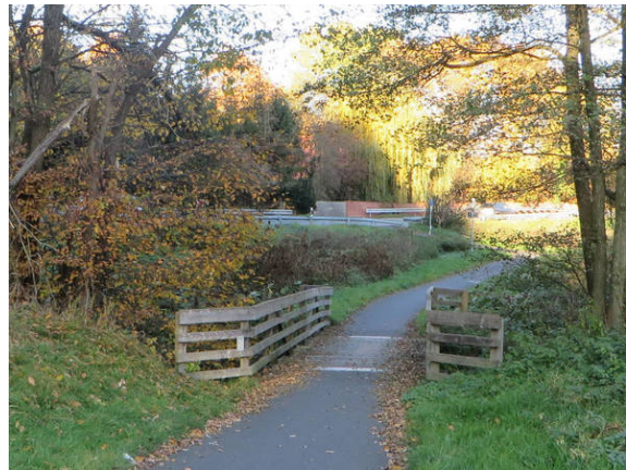
Bild 2: Blick auf die Holzbrücke mit der Engstelle "Brückengeländer". Die Engstelle des holzbraunen Geländers ist vor allem bei Dunkelheit schwer auszumachen.
