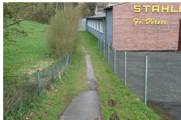
Bild 2: Blick am Südbeginn der Route (altes Motiv vor Ausbau).
