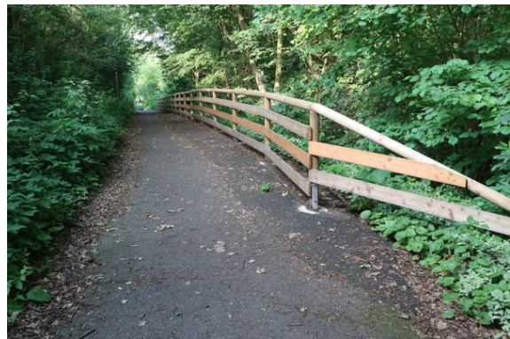
Bild 2: Blick talwärts auf den oberen Beginn des Geländers. Seitlich wäre hier eine rot-weiße Reflektorbake wichtig.
