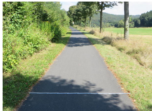
Bild 2: Wegbreite gerade mal 2 m. Für eine hoch frequentierte Strecke wie den R1 ist das zu wenig.
