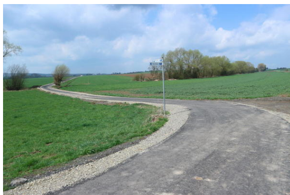
Bild 3: Auf der Neubaustrecke mit Blickrichtung Espenau
