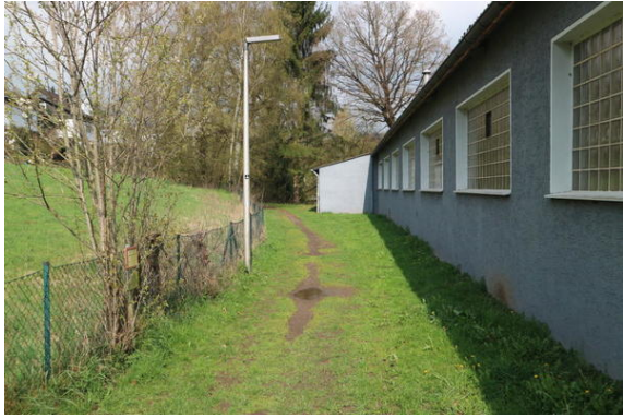
Bild 3: Auf der Route mit "feuchter" Wegoberfläche (altes Motiv vor Ausbau).
