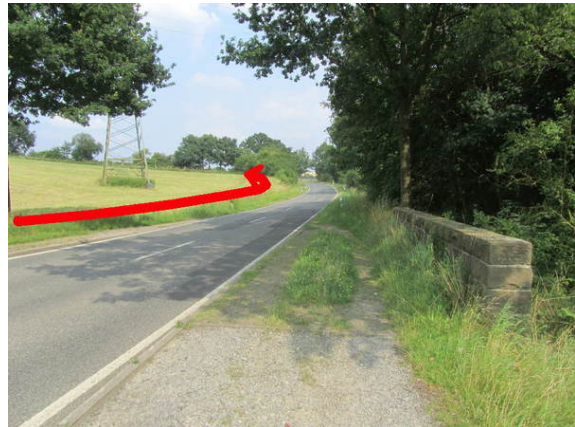
Bild 2: Blick auf die K 39: nördlich der Kreisstraße verläuft die RVA-Trasse.
