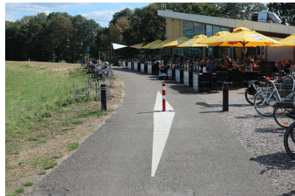
Bild 4: Niederlande: So stellt man Pfosten auf einer Radroute mit etwa 3 m Breite sicher auf: Es gibt drei Pfosten mit jeweils zwei Fahrspuren. die äußeren Pfosten sind zwars dunkel, besitzen aber ebenfalls Reflektoren. Besser wären hier natürlich auch noch rot-weiße Pfosten.
