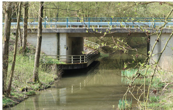
Bild 2: Blick auf die überhängende Konstruktion.
