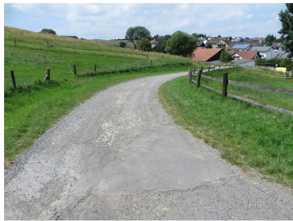
Bild 2: Blick talwärts Richtung Simmershausen mit holpriger Schotterdecke mit Altpflasterresten
