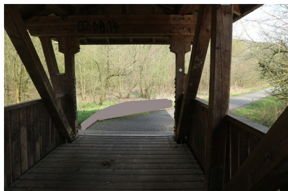
Bild 4: Sicht von Brücke auf potentielle, neue Radiusaufweitung
