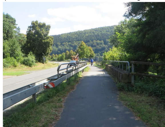
Bild 4: R1 Höhe Kläranlage
