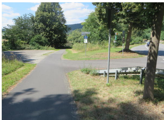
Bild 3: R1 am Parkplatz Elsterbach
