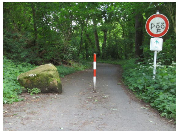
Bild 2: Blick auf die Sperre talwärts 2014. RV-Freigabe fehlt ferner: Zusatzschild anbringen
