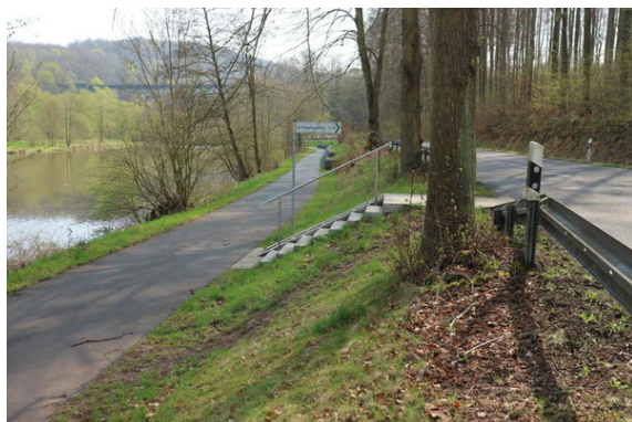
Bild 3: Seitlicher Blick auf die Treppe. Vorne vor der Treppe hat sich eine "MTB-Abfahrt" bzw. ein abfallender Trampelpfad gebildet.
