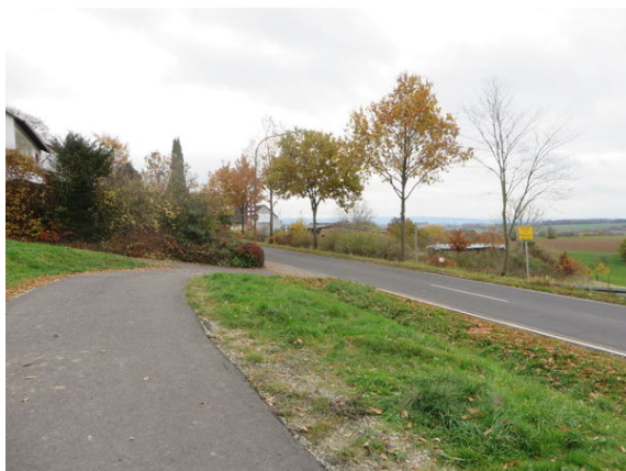
Bild 3: Ortseingang Rothwesten: Am südlichen Bestandsstück ist sichere eine RV-Ausleitung mit Mittelinsel notwendig. Diese sollte mit dieser Maßnahme ebenfalls hergestellt werden.
