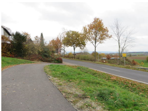
Bild 3: aktuell nicht bedarfsgerechtes RVA-Ende. Mit umsetzung von Maßnahme ESP_5 ist hier eine RV-Ausleitung mit Mittelinsel notwendig.
