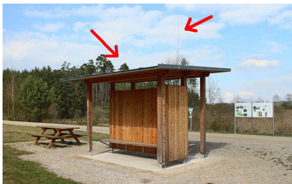
Bild 3: Fränkisches Seenland: Dieser Radwanderrastplatz am Großen Brombachsee besitzt eine blitzschutzsichere Schutzhütte mit Metaldach und zwei Blitzableitern.
