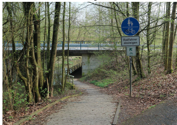
Bild 4: Blick von Westen auf die steile Rampe.
