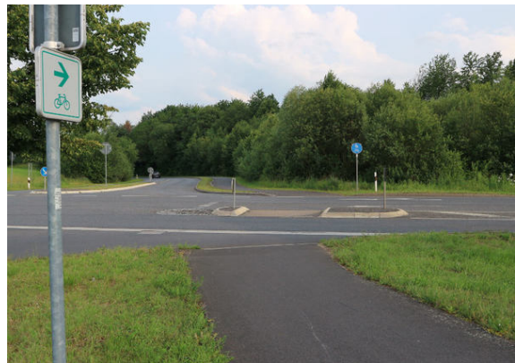
Bild 2: Blick auf die Querung mit schmaler Mittelinsel
