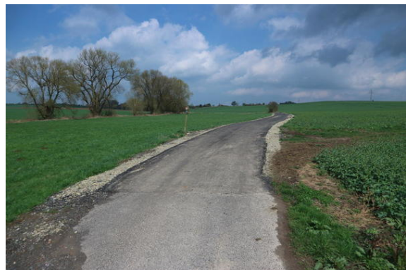
Bild 2: Beginn der neuen Asphaltdecke von Simmershausen kommend.
