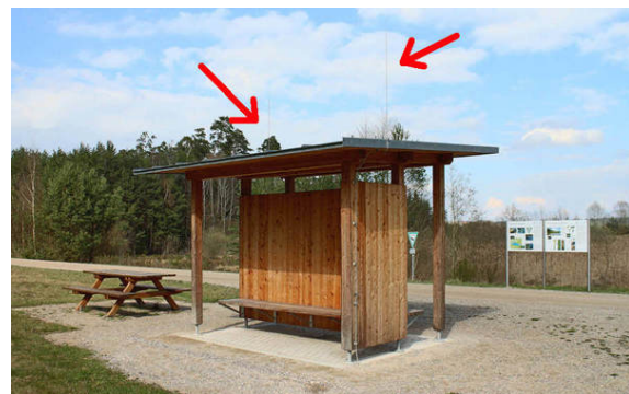
Bild 2: Fränkisches Seenland: Dieser Radwanderrastplatz am Großen Brombachsee besitzt eine blitzschutzsichere Schutzhütte mit Metaldach und zwei Blitzableitern.
