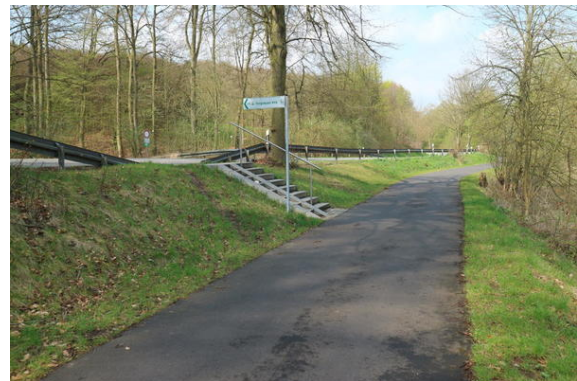
Bild 2: Abzweig der Nebenroute mit Treppe.
