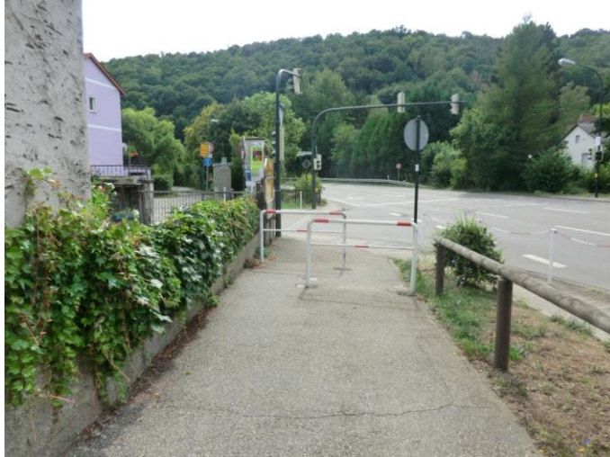
Abbildung 16: Umlaufsperrung entlang der Kaiserlauterer Straße bei Grethen [Foto: R+T].
