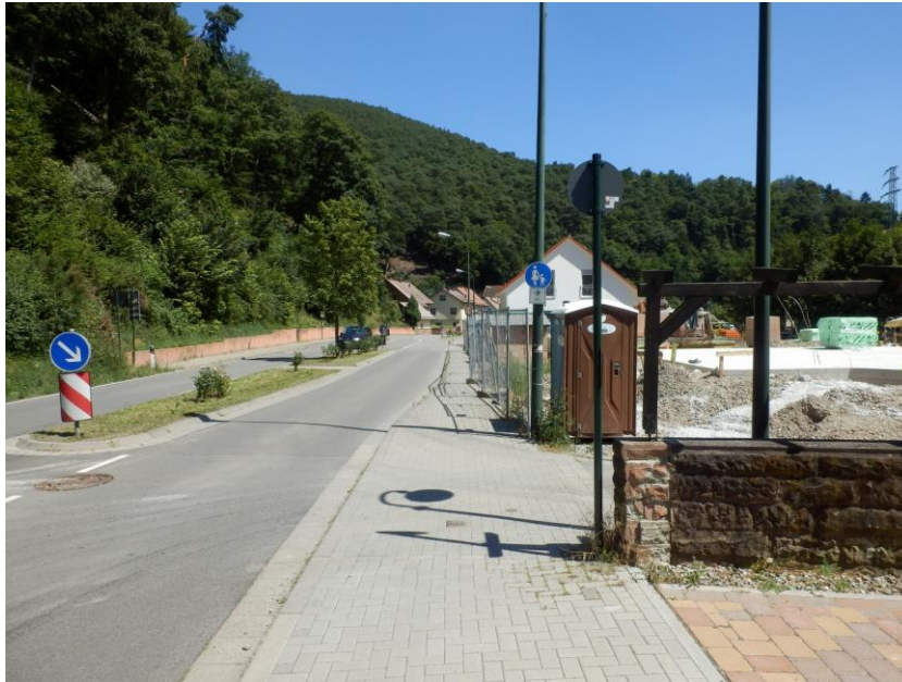
Abbildung 12: Radwegende ohne Ausleitung in den Mischverkehr in der Kaiserslauterer Straße. 11
