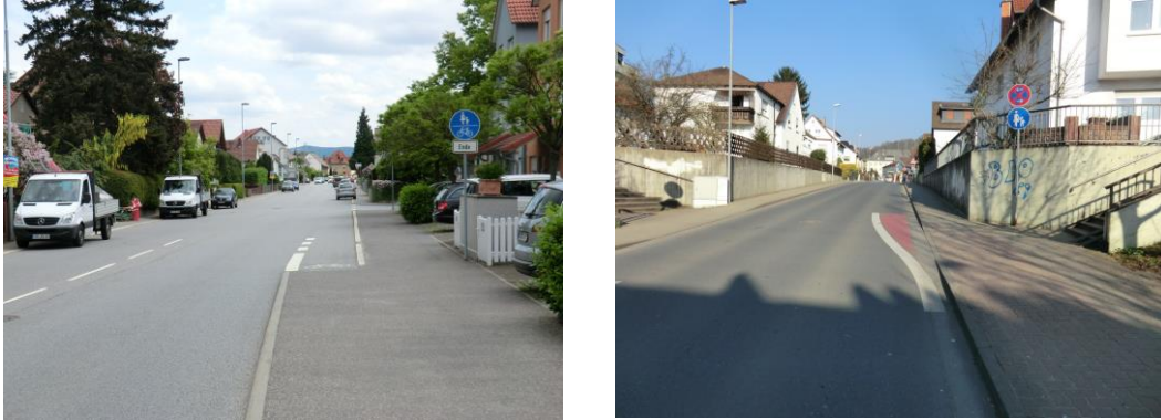
Abbildung 13: Beispiele für gut gelöste Ausleitungen auf die Fahrbahn. Links: Musterlösung / Rechts: Minimallösung [Fotos: R+T].
