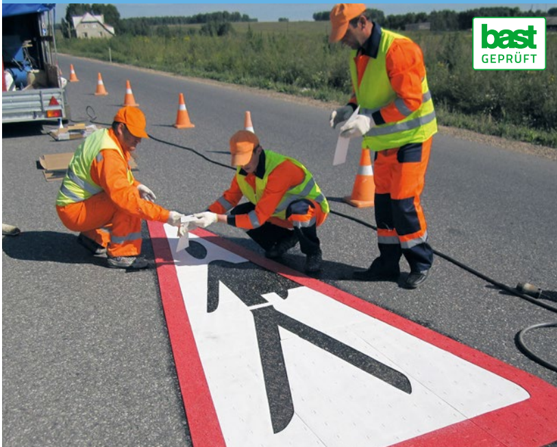
Premark-Markierungen können großflächig auf die Straße aufgetragen werden. Sie übermitteln ein deutliches Signal für Verkehrsteilnehmer.
