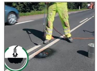
Geringer Aufwand: Sie benötigen nur einen Straßenbesen und einen Gasbrenner
