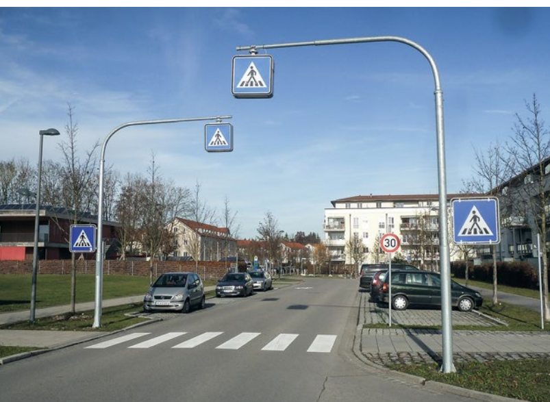
Komplette Montage eines Fußgängerüberwegs
