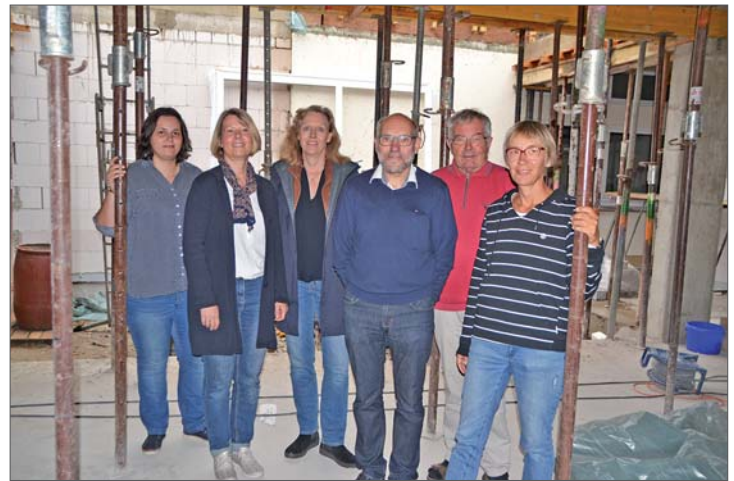
Noch ist der Anbau des evangelischen Kindergartens im Rohbau. Bauleiterin Mailin Köhne, Architektin Anke Nollkämper, Dagmar Pahlmeyer, Jürgen Deichsel und Fritz Ellerweg aus dem Presbyterium sowie Einrichtungsleiterin Claudia Krüger (v.l.) sind zuversichtlich, dass die Fertigstellung im November erfolgt.
