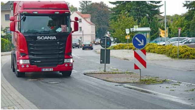
Mittelinsel als Querungshilfe für Fußgänger und Radfahrer, Leitplatte ist innerorts entbehrlich
