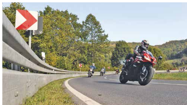
Stahlschutzplanke mit Unterfahrschutz auf Motorradstrecke
