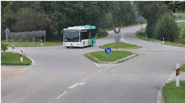
Fahrbahnteiler an einer Außerortskreuzung
