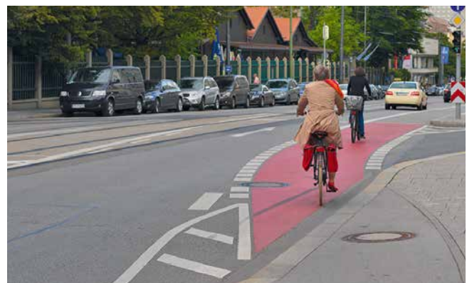
Überleitung eines baulichen Radwegs auf die Fahrbahn
