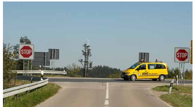
Zur Verdeutlichung beidseitig aufgestelltes Stoppschild in Übergröße auf Trägertafeln
