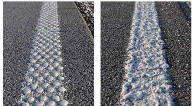
Fahrbahnmarkierungen mit verbesserter Nachtsichtbarkeit bei Nässe (Typ II)
