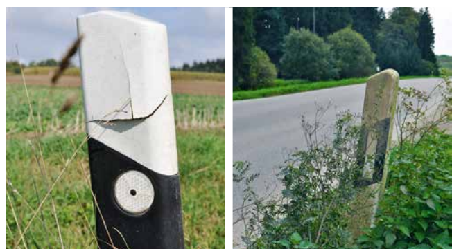
Leitpfosten (schlechter Zustand)
