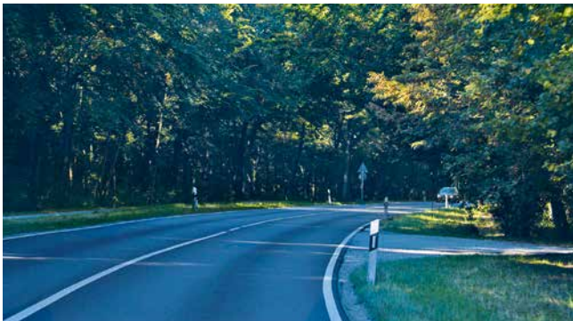
Schlecht einsehbare Anbindung eines Wirtschaftsweges an eine Außerortsstraße
