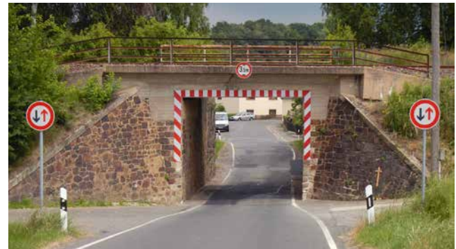
Leitmale an einer Unterführung mit eingeschränkter Höhe und einstreifiger Verkehrs-führung
