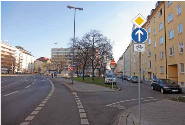
Z 211 an einer Einbahnstraße
