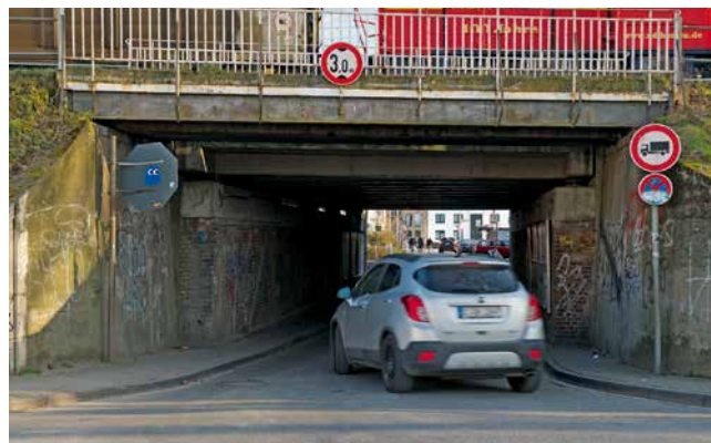
Verkehrsverbot für Lkw und Höhenbeschränkung an einer Unterführung
