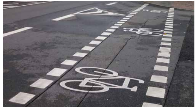
Radverkehrsfurt im Zuge einer Vorfahrtstraße
