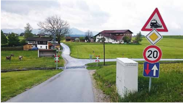
Einstreifige Verkehrsführung am Bahnübergang und Vorfahrtregelung innerhalb der Räumstrecke
