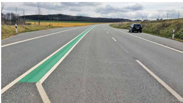
Fahrbahnmarkierung für 2+1 Querschnitt EKL 1 nach RAL
