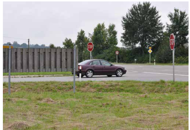
Sichtblende bei unzureichender Annäherungssichtweite
