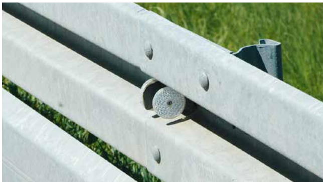
Reflektor an Stahlschutzplanke
