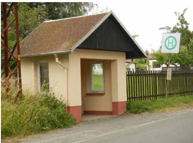
Wetterschutzeinrichtung an einer Haltestelle
