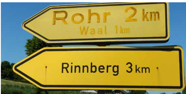
Pfeilwegweiser mit unterschiedlichen Ausführungen, Abmessungen und Schriftgrößen (schlechter Zustand)
