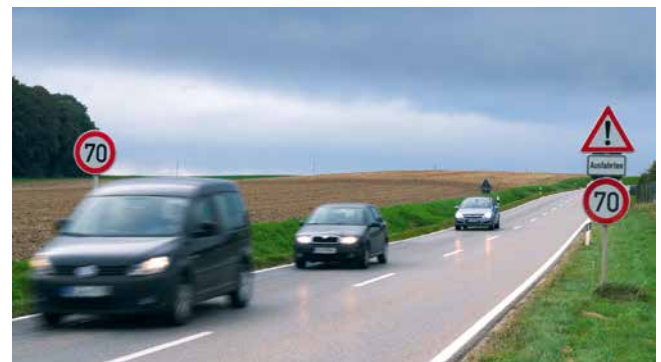
Gefahrzeichen und Geschwindigkeitsbegrenzung an Grundstückszufahrt
