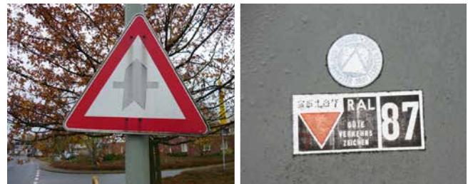
Verblasstes und überaltertes Verkehrszeichen
