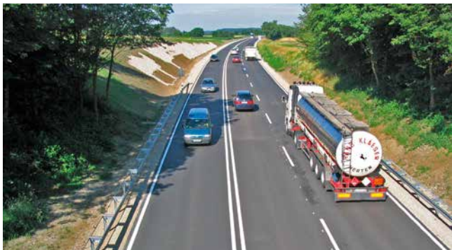
Fahrbahnmarkierungen auf Außerortsstraße (2+1-Querschnitt)
