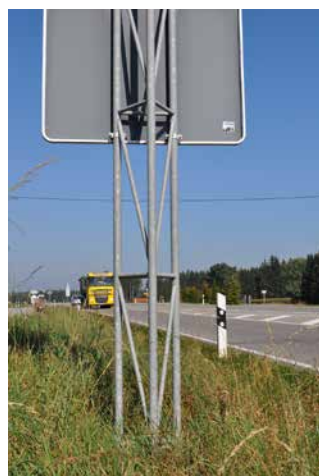
Aufstellvorrichtung für Verkehrszeichen als Dreiecksgabelständer
