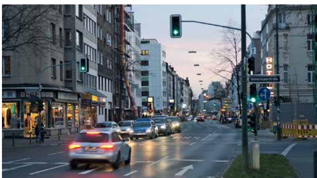
Separat signalisierter Linksabbiegestreifen an einer Lichtsignalanlage
