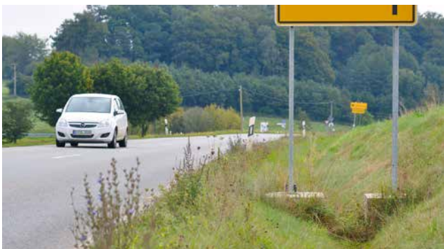
Fundamente von Verkehrszeichen sind Hindernisse im Seitenraum
