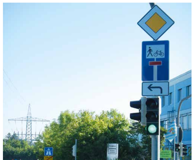
Schwer verständliche Kombination aus Z 306 und Z 357 und Z 1000-11
