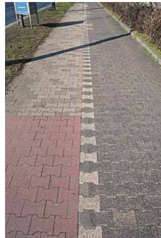
Farbliche Abgrenzung des Radwegs vom Gehweg, jedoch ohne taktile Führung
