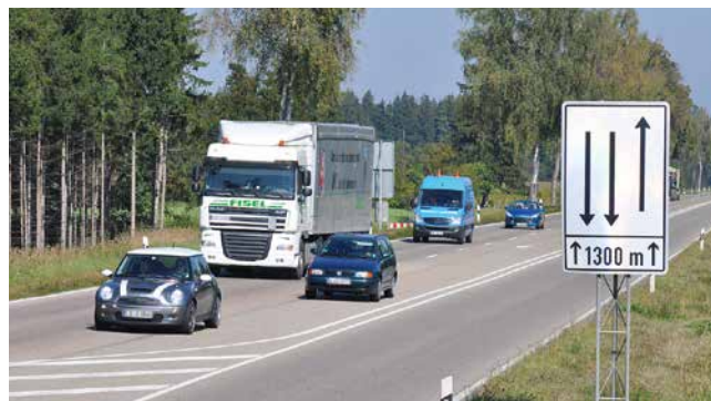
Dreistreifiger Fahrbahnquerschnitt außerorts
