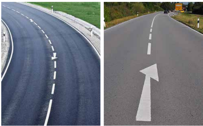
Warnlinie und Vorankündigungspfeile vor einer durchgehenden Fahrstreifenbegrenzung
