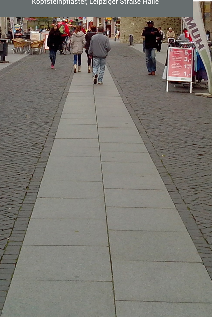
Abbildung 10 Plattenbelagführung zwischen Kopfsteinpflaster, Leipziger Straße Halle
